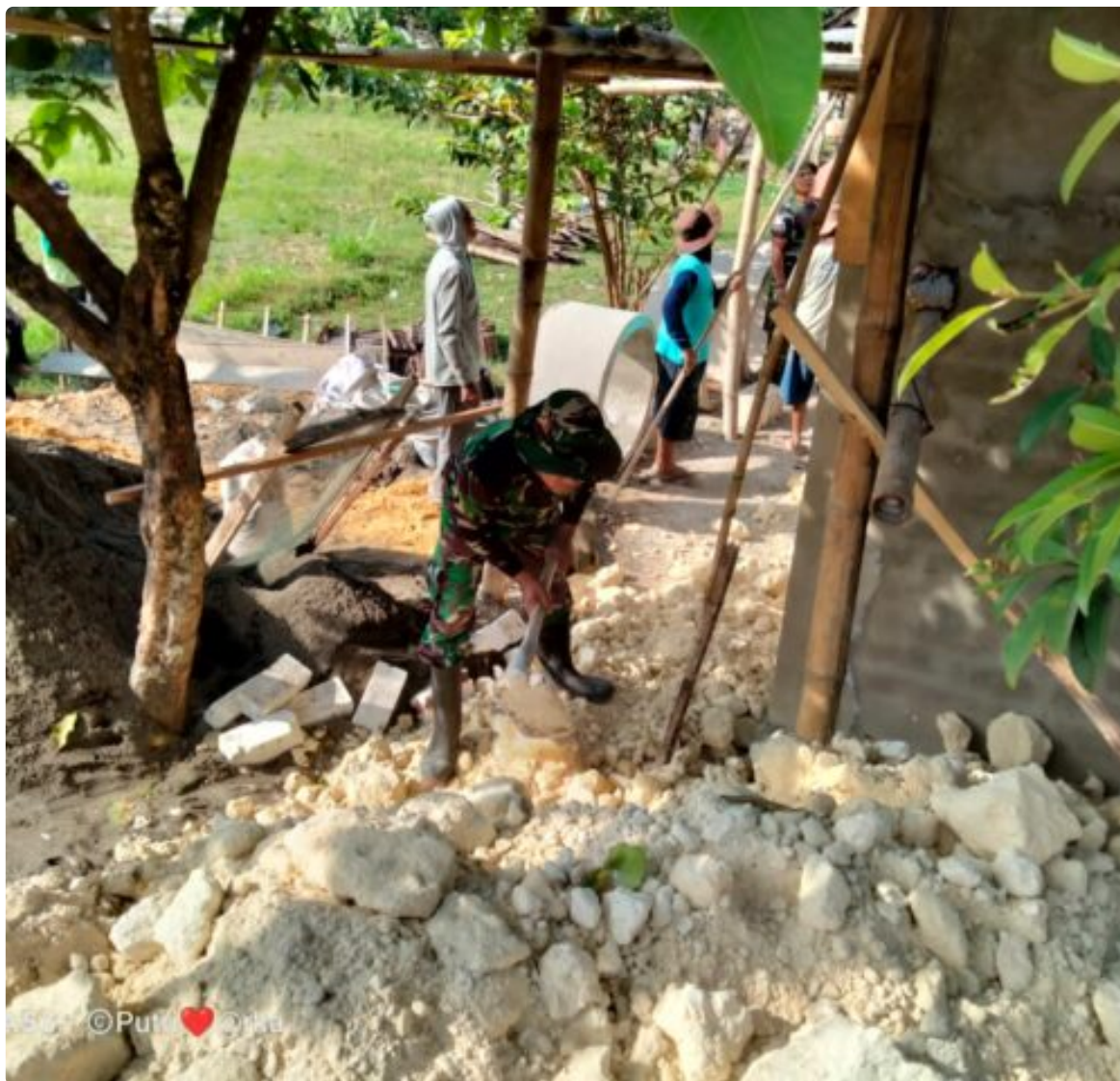
pembangunan Mushola Mamba'ul Hikmah di Desa Nguluhan Kecamatan Montong Kabupaten Tuban, Sabtu (03/09/2022).
